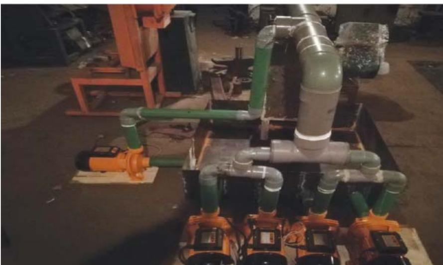
C'est le refoulement d'une série de pompes de surface dont le démarrage est amorti par le principe des vases communicants.
