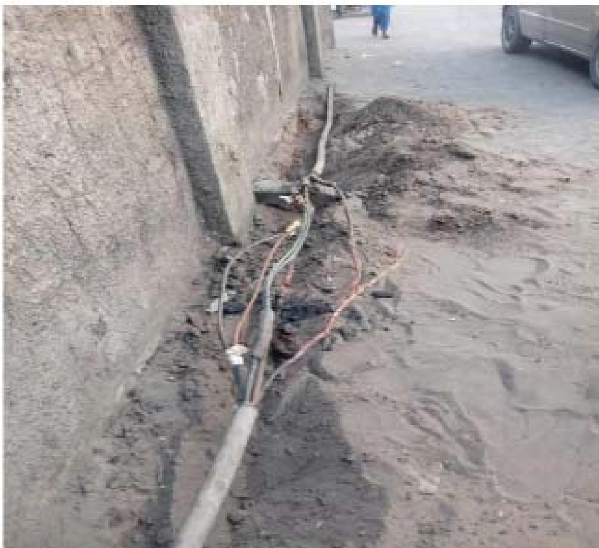
Ainsi pour pallier cette situation, nous avons mis au point des manchons dénommé : « **Manchbol** », cela pour arrêter définitivement les brûlures des boîtes des jonctions en réduisant sensiblement la chaleur au point des connexions des deux bouts des câbles.
